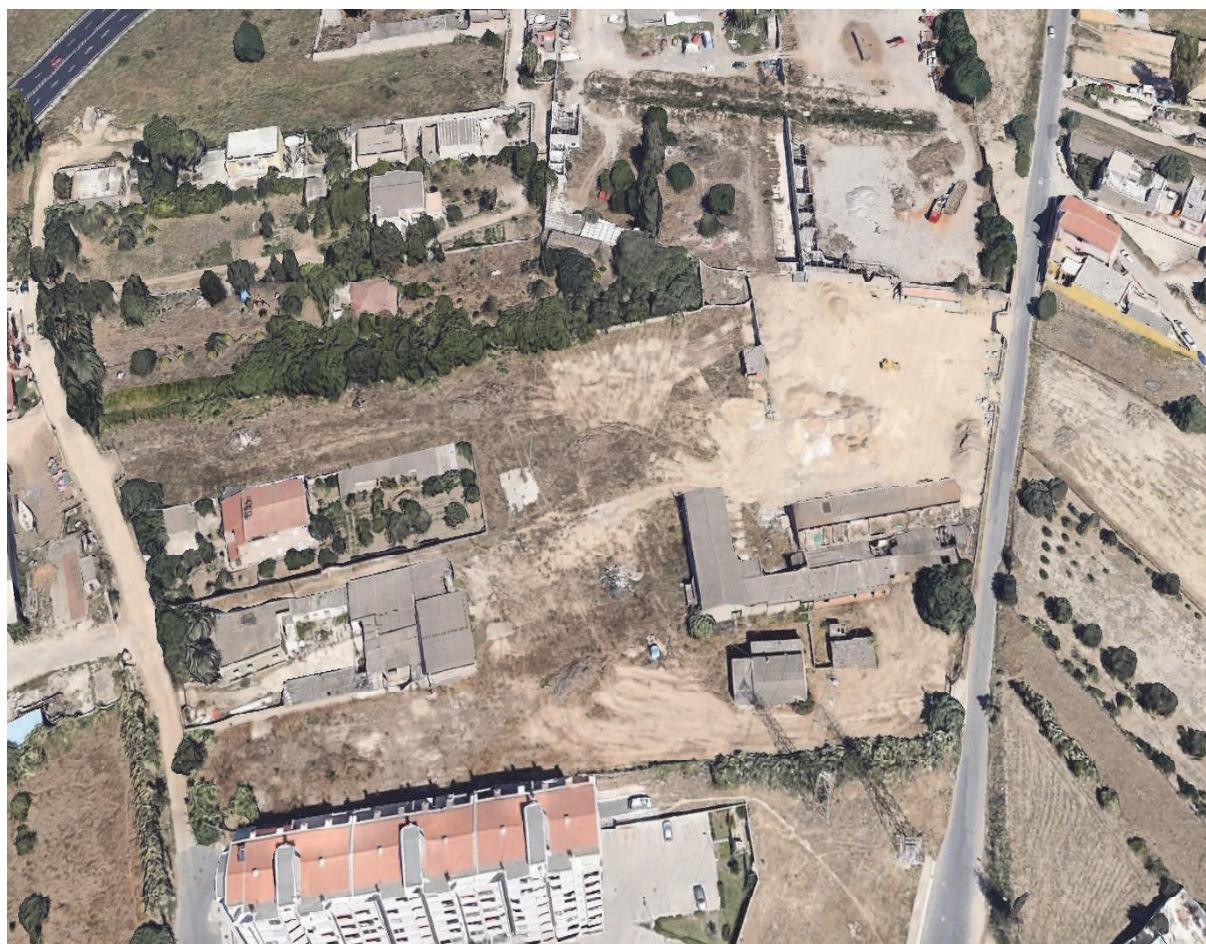
Figura 1 - Veduta aerea dell'area di intervento
